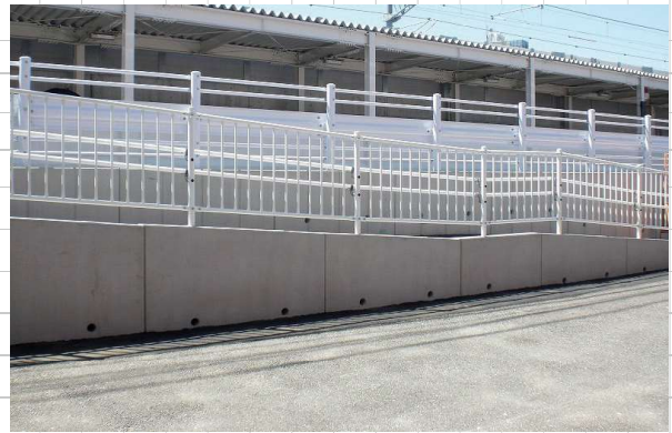
■ 製品施工事例
