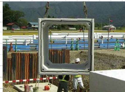
■ 製品施工状況
