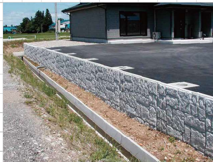
■ 製品施工事例 (表面擬石タイプ: 標準は滑面です)
