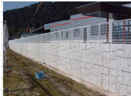
■ 製品施工事例 (表面擬石タイプ: 標準は滑面です)
