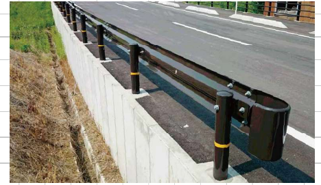
■ 製品施工事例
