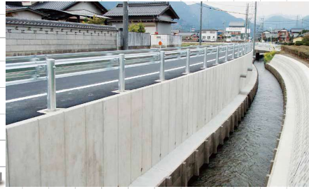
■ 製品施工事例
