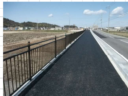
■ 製品施工事例
